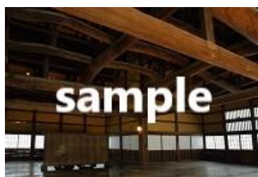
2、庫裏内部小屋組
